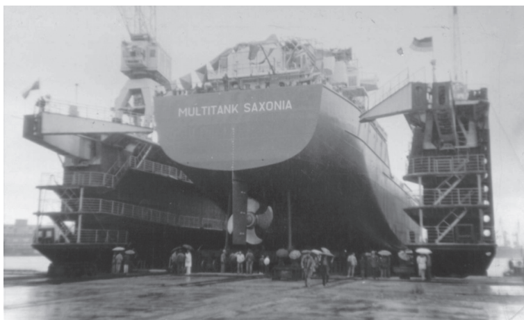
Рис. 1.14. Передача судна с горизонтального стапеля Балтийского завода на передаточный плавдок Адмиралтейских верфей
