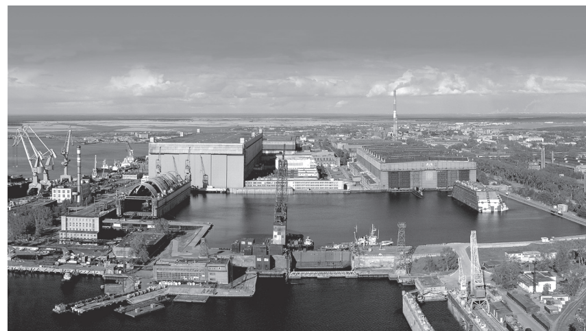
Рис. 1.8. Наливной бассейн одного из отечественных судостроительных заводов (бассейн заполнен перед выводом суперблока основания шельфовой платформы, на заднем плане — крытые эллингами наливные доки)
