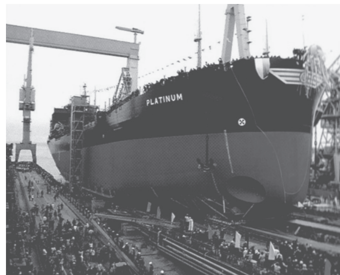
Рис. 1.4. Спуск судна со стапеля Черноморского судостроительного завода в г. Николаев
