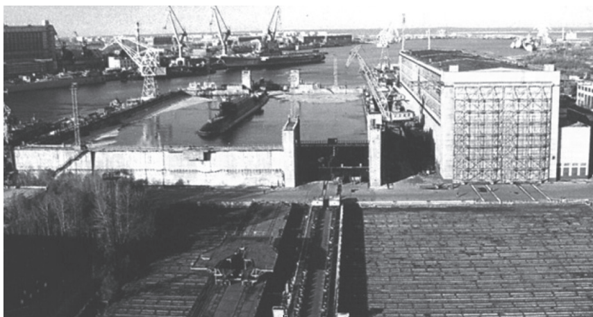
Рис. 1.11. Наливная камера судоремонтного завода.
