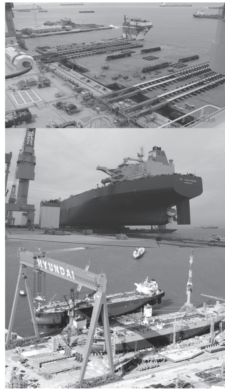
Рис. 1.17. Стапельный комплекс с поперечной накаткой на плавучее спусковое устройство (ННН, Offshore & Engineering Division, г. Ульсан, Южная Корея)
